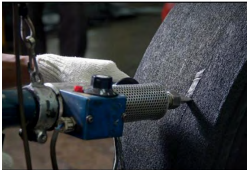
รูปที่ 13 การเติมยางคุชชั่นกัมลงในรอยแผลที่ถูกขัดแต่ง
